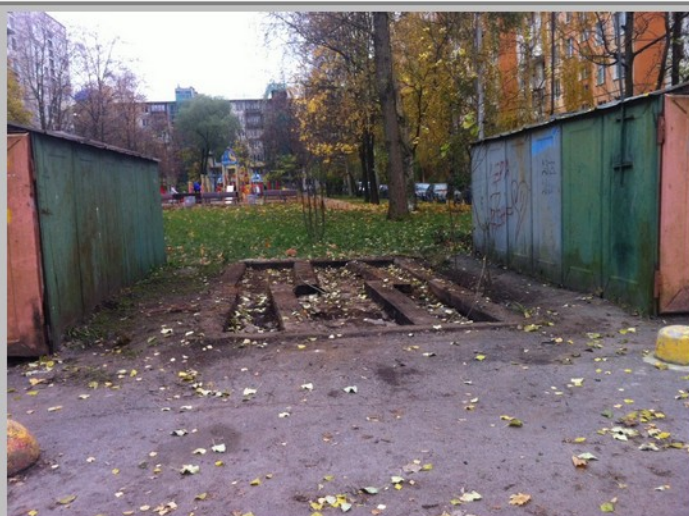
После демонтажа гаража ул.С.Ковалевской д.5 корп.6
