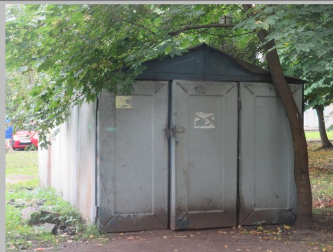
До демонтажа гаража Кондратьевский пр. д.63 корп.2
