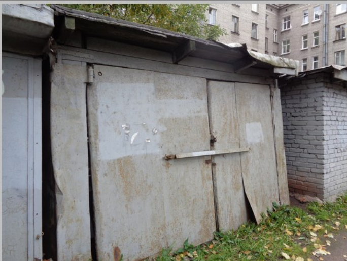
Гараж до демонтажа ул.Лабораторная д.9
