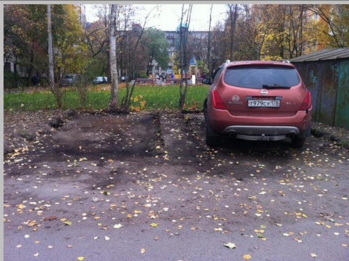
После демонтажа гаража ул.С.Ковалевской д.5 корп.6
