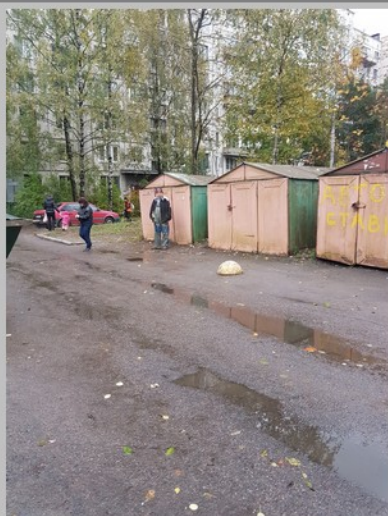
До демонтажа 3-х гаражей ул.С.Ковалевской д.5 корп.6
