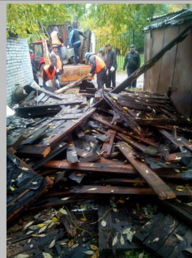
Демонтаж гаража ул.Лабораторная д.9
